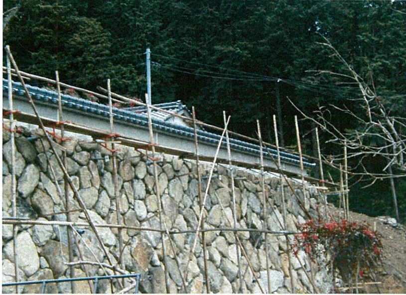
塗塀新築工事
